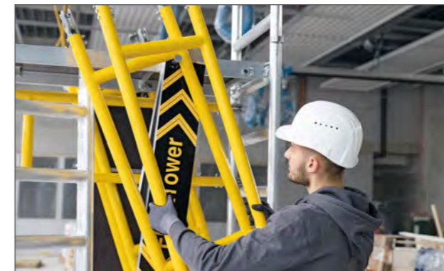
Praktische Einhängkonsole (ausziehbar) zur Mitnahme der Teile
