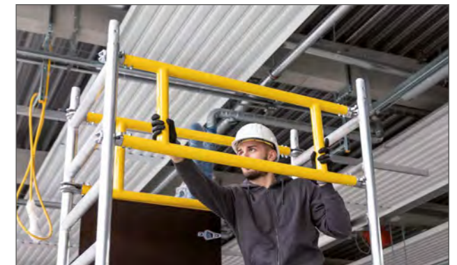
Montage im absturzsicheren Bereich dank 3-T-Methode
