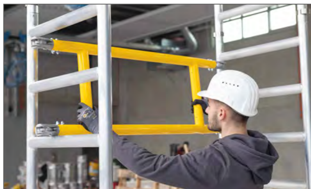
Pulverbeschichtete Geländerrahmen als Querstreben
